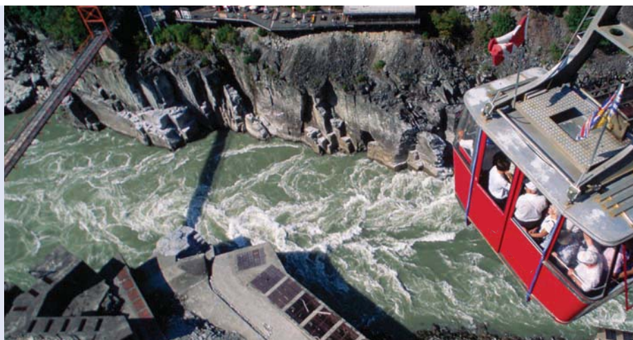
FIGURE 1-15 L'échelle à poissons de « Hell's Gate » a été construite en 1945 pour permettre aux saumons d'atteindre leurs frayères, situées en amont. Le courant est moins fort dans l'échelle à poissons que dans le canyon du fleuve Fraser.
