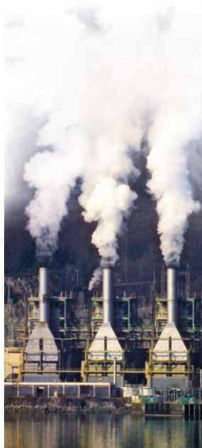
Figure 5.12 Les centrales électriques ont mis au point une technique qui fait appel à des produits chimiques pour « nettoyer » les gaz d'échappement afin d'éliminer des substances comme le dioxyde de soufre.
